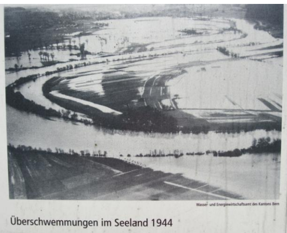
Überschwemmungen 1944 oberhalb Solothurn: (Bild von permanenter Ausstellung in Altreu)
