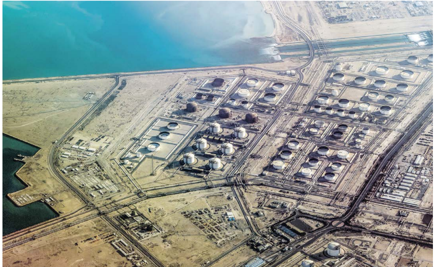
Trotz enger Beziehungen zum Iran wurde Katar angegriffen: Teil einer Flüssiggasanlage in Ras Laffan drei Tage vor Kriegsausbruch.
